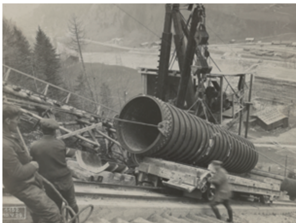
Bau des Vermuntwerks in Partenen, 1929, Foto: illwerke vkw
